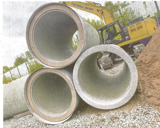
Die drei Meter langen Rohrstücke sind von innen mit Eisen verstärkt, damit sie dem Druck standhalten.
