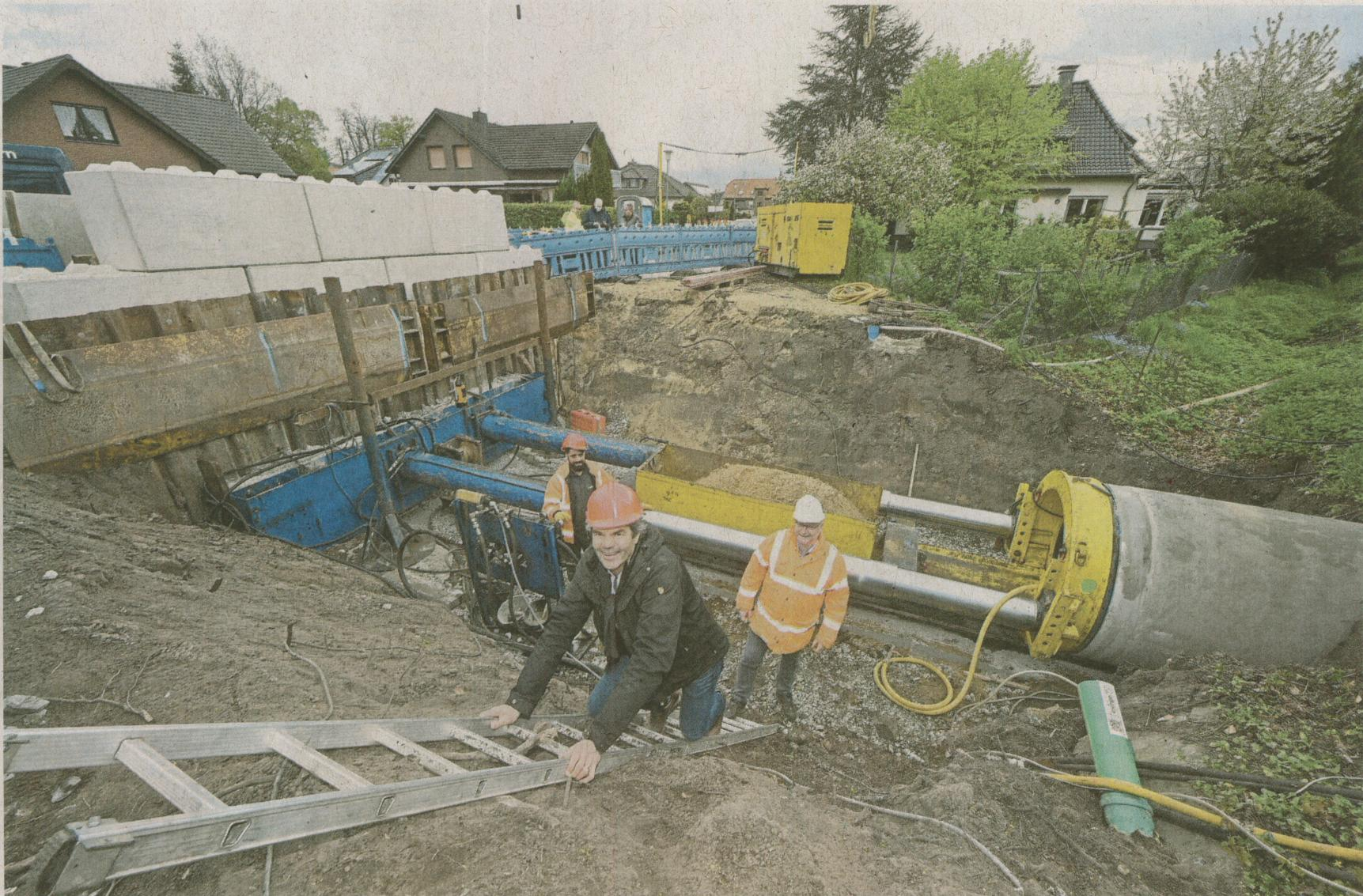
Mehrere Meter tief ist die Startgrube für das Tunnelbauverfahren an der Südstraße zur Unterquerung der B64. Verantwortlich für Planung und Bauleitung der Gesamtmaßnahmen zum Bau und Anschluss der verbesserten Regenwasserkanalisation ist Diplom-Ingenieur Donald Welling (auf der Leiter). Ausgeführt werden die speziellen Arbeiten von der Firma ARS aus Marsberg, hier beim Fototermin mit Geschäftsführer Diplom-Ingenieur Albert Römer-Schmidt und Mitarbeiter Ramazan Türkoglu.
