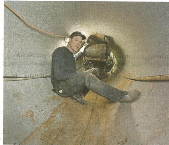
Marco Weiß an seinem Arbeitsplatz: Beim bemannten Tunnelbauverfahren ist er vorn an der Spitze des Pressrohres dafür verantwortlich, dass Boden aus dem Rohr gebracht wird. Foto: Oliver Schwabe
