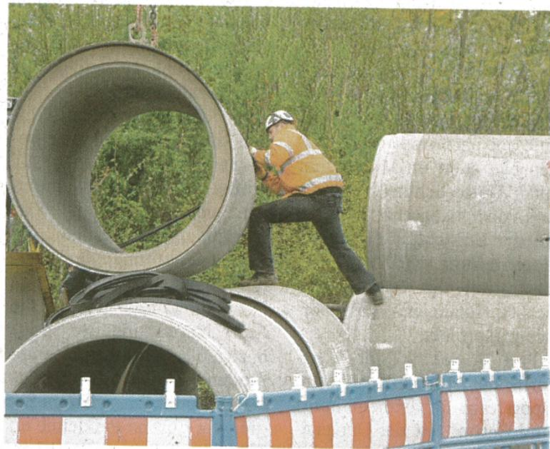
Ganz schön wuchtig sind die Pressrohre aus Stahlbeton. Sie haben einen Innendurchmesser von 120 Zentimetern und werden im Tunnelbauverfahren in Delbrück grabenlos verlegt. Foto: Oliver Schwabe
