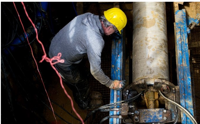
Im Mikrotunnelbau mit Schneckenfördersystem werden die Vortriebsrohre aus Polymerbeton durch einen Bohrkopf vorgetrieben.
