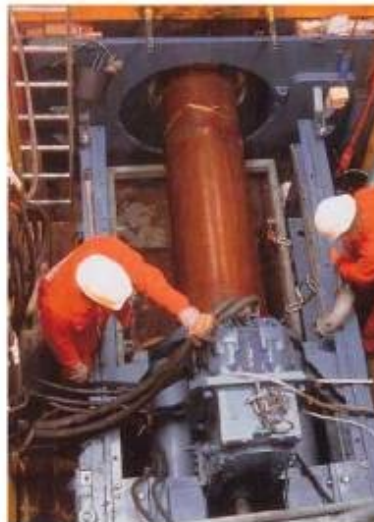
Blick in die Baugrube beim gesteuerten Microtunnelvortrieb mit Steinzeugvortriebsrohren DN 400
