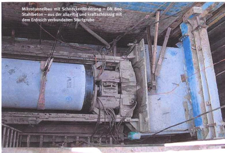
Mikrotunnelbau mit Schneckenförderung – DN 800 Stahlbeton – aus der allseitig und kraftschlüssig mit dem Erdreich verbundenen Startgrube
