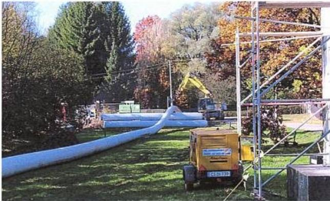
Abb. 4 Verschweißter PE-Rohrstrang vor Einzug
