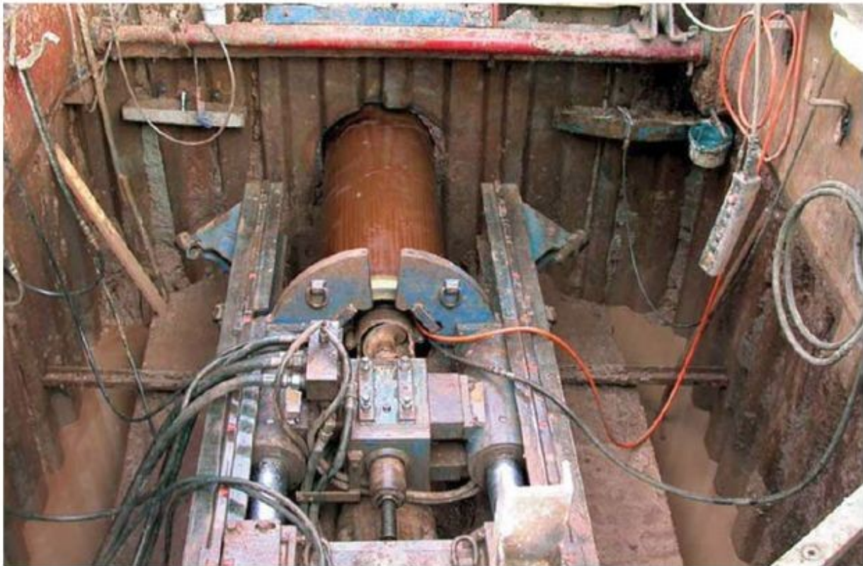
Als Neurohre wurden Steinzeug-Vortriebsrohre DN 400 verwendet. Die Hausanschlüsse wurden nach dem Vortrieb mit Anbohrung und Anschlussstutzen übernommen.
