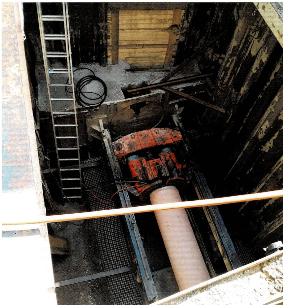
Blick in die Startbaugrube für den Vortrieb DN 400 mit Steinzeug-Rohren
