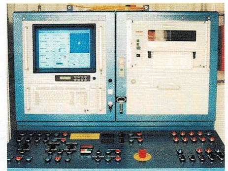
Steuerstand einer Mikrotunnelanlage mit Schneckenförderung. Die für den Vortrieb relevanten Daten wurden alle 10 cm aufgezeichnet und protokolliert. | Fotos und Abbildung: ARS Rohrvortrieb
