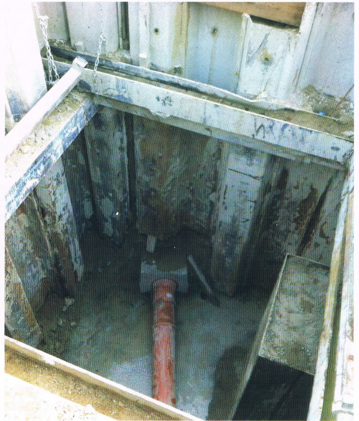
Für den Einfahrvorgang vorbereitete Zielbaugrube Wittekindstraße | Foto: Lindschulte Ingenieure + Architekten
