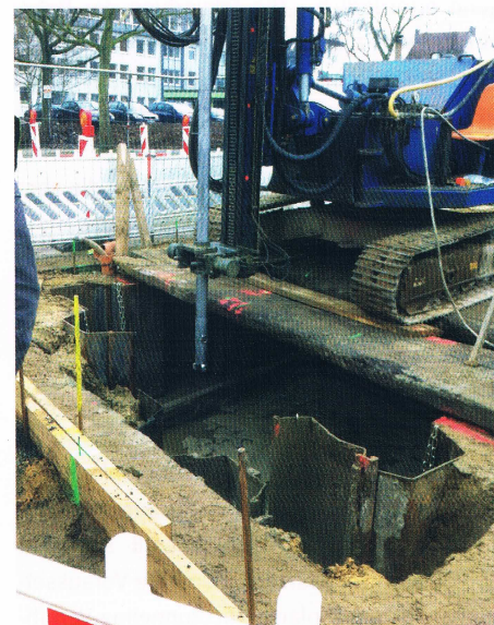
Herstellung der Schwergewichtssohle mittels HDI-Verfahren an der Zielbaugrube Wittekindstraße
