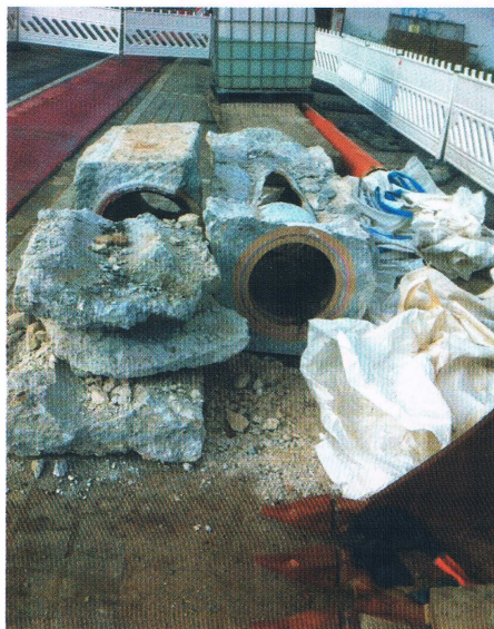
Betonummantelter Schmutzwasserkanal aus Steinzeugrohren DN 400 | Foto: Stadtwerke Osnabrück
