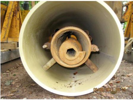
Vor dem Einbau der GFK-Vortriebsrohre DN 600 wurden die mit Förderleitungen- und Schnecken bestückt.
