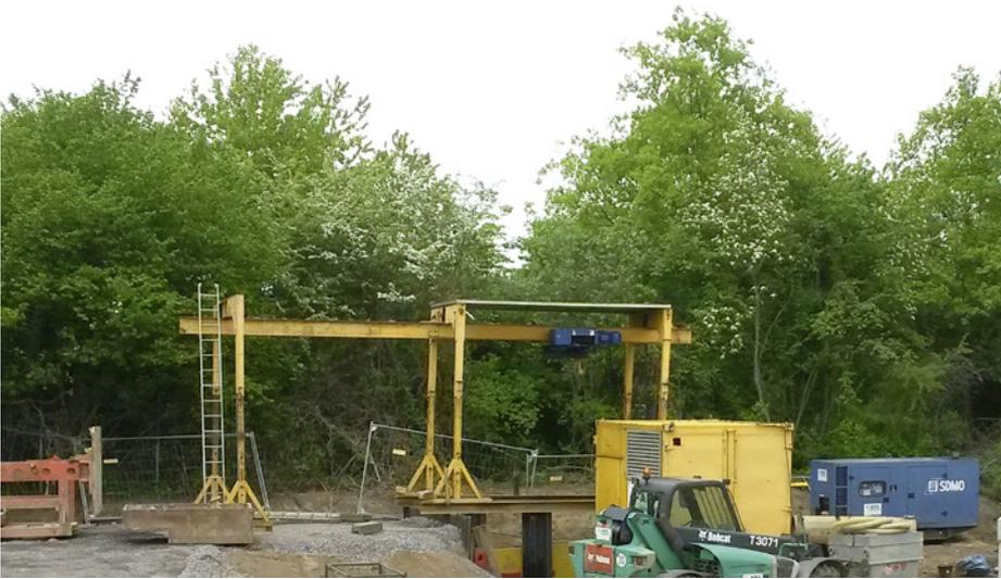
Kompakte Mikrotunnelanlage mit Schneckenförderung an der Startgrube eingerichtet
