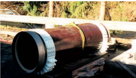
Abb. 4 ■ Ein Steinzeug-Inlinerrohr DN 600 mit Gleitkufen vorbereitet zum Einziehen oder Einschieben
