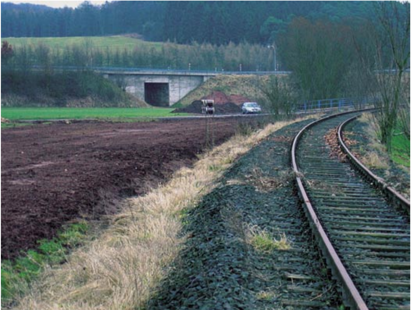
In dem Baulos 1 der Abwasserableitung von Korbach nach Dorfitter musste insgesamt 3 mal die Gleisanlage und die im Hintergrund im Damm liegende Bundesstraße 252 gequert werden.
