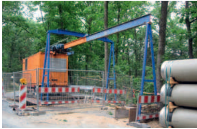
► Abb. 5 – An der Startgrube wurde eine kompakte Mikrotunnelanlage mit Schneckenförderung eingerichtet.
