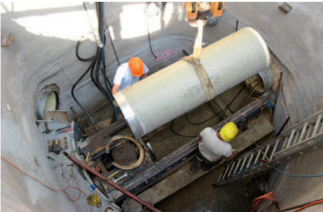
▲ Abb. 3 – Einbau eines GFK-Fertigteilschachtes
