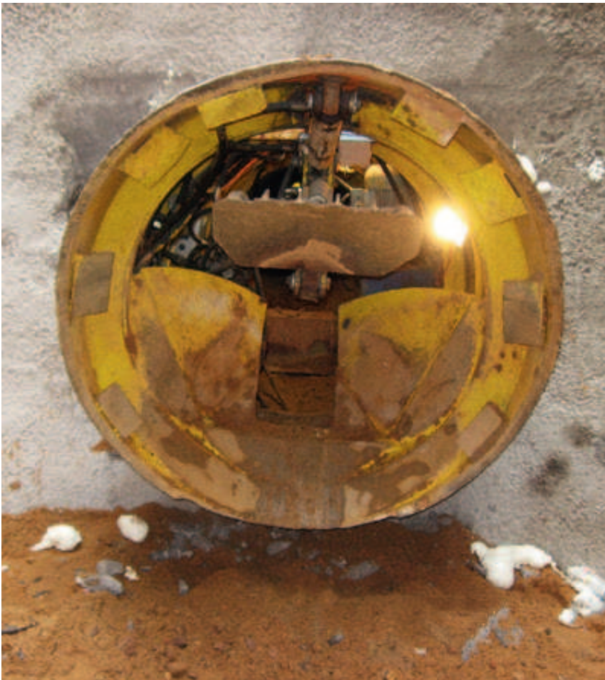
▼ Abb. 6 – Der Vortriebskopf mit „offenem Schild“ erreicht die Zielbaugrube.
