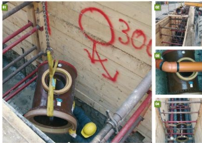
Bilder 1 - 4 Die Stadt Nürnberg baut auf Steinzeugrohren - hier Hochdruck DN 800. Das Bauelement, die Abzweig DN 800/300/140/90, wird in den Stocken herabgelassen (1 und 2). Hochdruck als Probe des Bauelementes DN 800 (3). Insgesamt 40 m ist die Leitung lag (4). Ort ist alleine laut den Abbildungen der veranschaulicht Holzbohrerbohrer.
