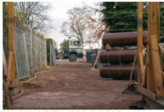
Die Bohrer-Verfahrenstechnik DN 400 lagern die „Bohrer“ an der Baustelle.
