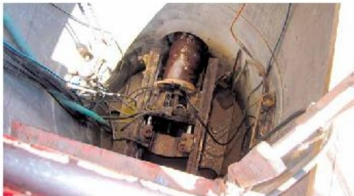
Blick in die Stahlbetonabsenkschacht DN 2000. Mit einem Außendurchmesser von ca. 2400 mm kann diese Startgrubenbauweise in der Regel überall eingebaut werden.
